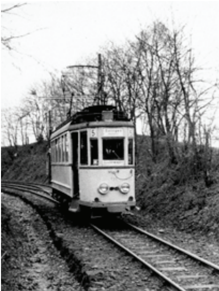
Tw 156 auf Sonderfahrt am 26. April 1969 an der unteren Weiche Greuel. Die Begrenzung der Gleisbettung ist deutlich zu erkennen.
