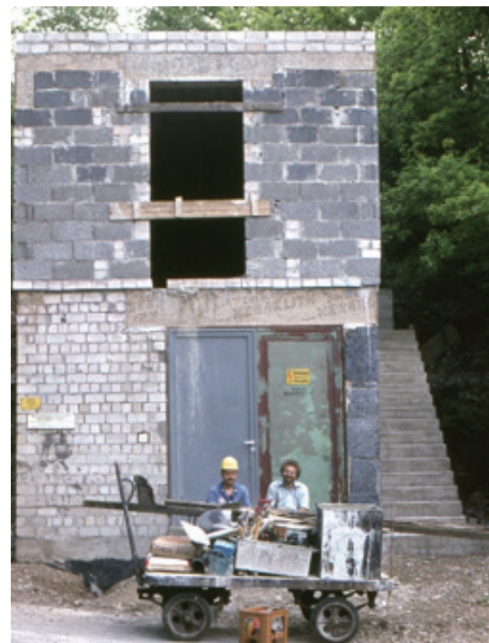
Die Bautruppe verbrachte Jahre am Schütt, um das Gebäude für die Stromversorgung zu erstellen. Foto: Michael Malicke
