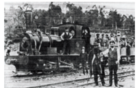
In der Chronik der Remscheider Straßenbahn von 1954 ist dieses Bild eines Bauzugs der Wermelskirchen – Burger Eisenbahn von 1889 an der Remscheider Talsperre zu sehen. Foto: Sammlung Klaus Sieper
