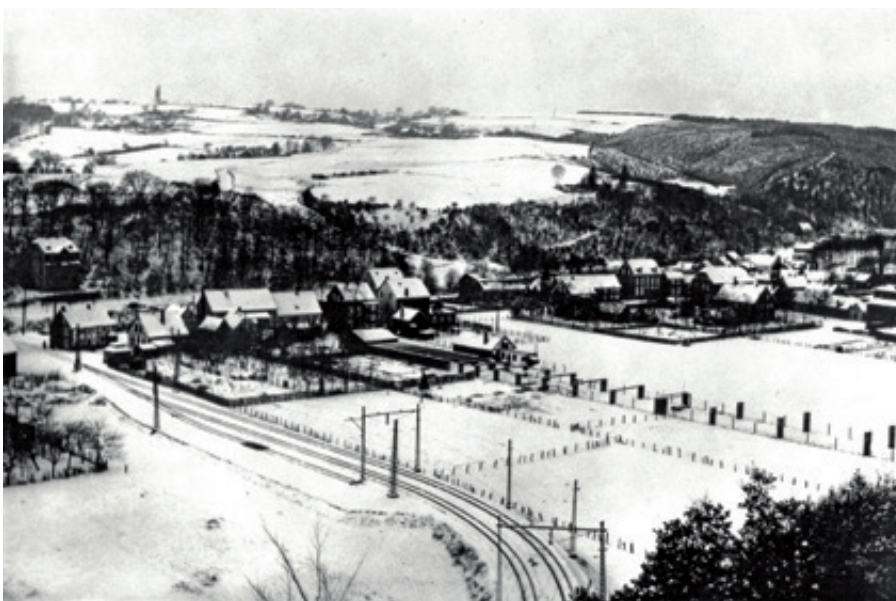
Blick auf die Gleisanlagen in der Kohlfurth 1927. Eindrucksvoll die zweigleisige Strecke mit den mächtigen Fahrleitungsportalen. Leider handelt es sich dabei nur um eine Art verlängerte Ausweiche. Foto: Archiv Hensel
