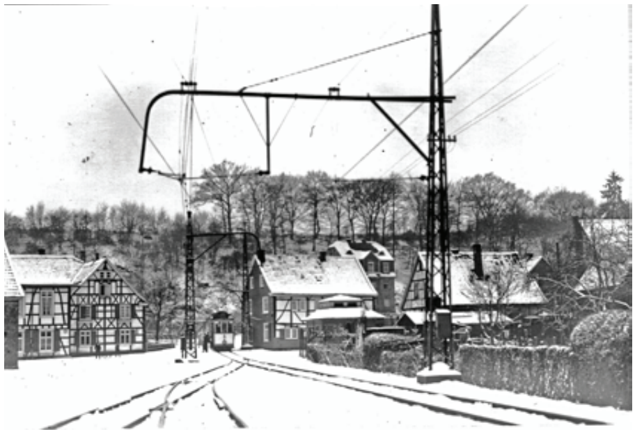
Ein Foto von Carl Bellingrodt mit der eisenbahngerechten Fahrleitung am heutigen Betriebshof der
