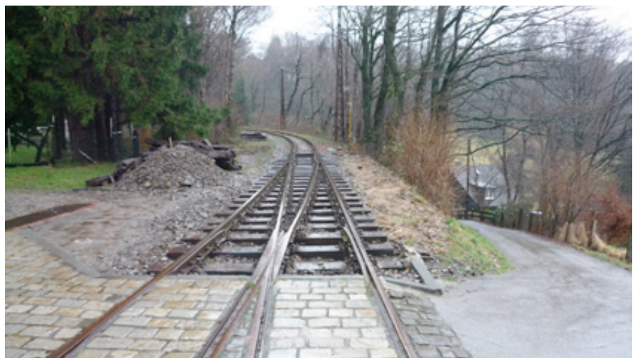
Ein Beispiel für den Weichenbau: Die obere Weiche Greuel am Neujahrstag 2013. So wird es auch 1952 ausgesehen haben, zwei alte Fahrleitungsmaste
