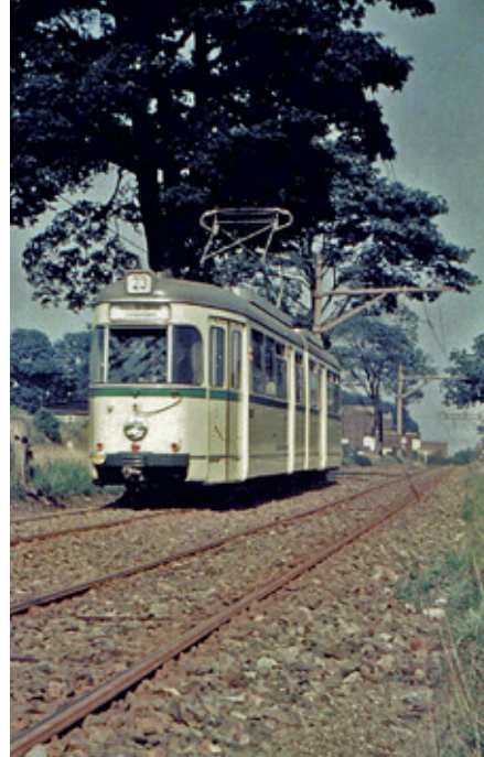
Probetrieb mit Triebwagen 262 der BoGeStra, hinter der Bahn rechts erkennen wir das Umspannwerk (Foto: Heinz Johann)
