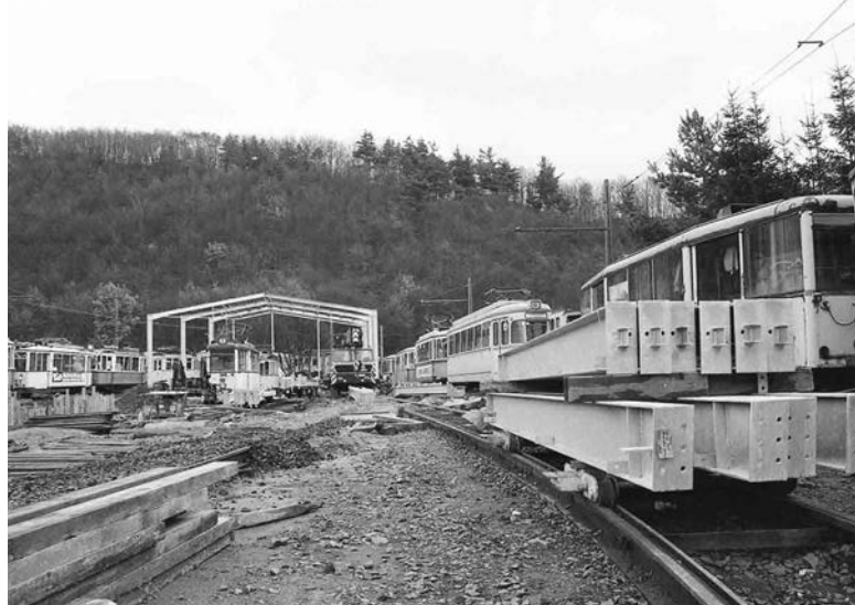
Auf solidem Fundament ein Dach über dem Kopf: Die Wagenhalle entsteht in Etappen. (1982)
