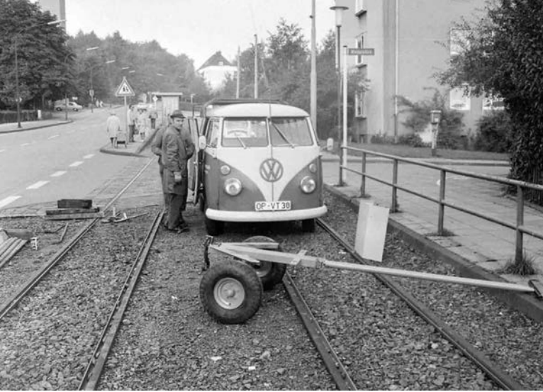
Wenige Jahre alt und schon ins Museum: Gleise auf der Hagener Strecke nach Emst-Bissingheim werden ausgebaut, u. a. für die Ausweiche Möschenborn (1978)
