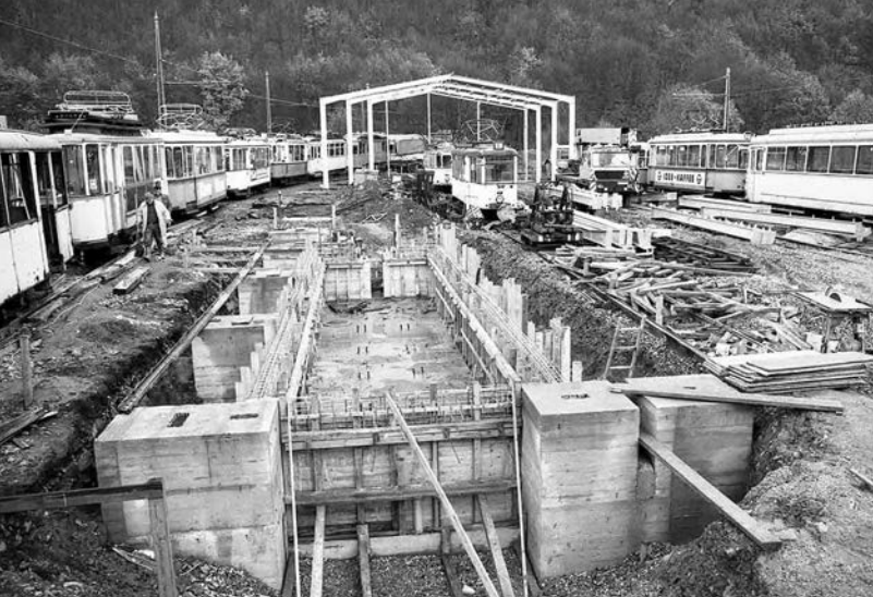
Das Fundament wächst: Massiver Beton in den Überschwemmungsausden der Wupper muss sein. (1982)
