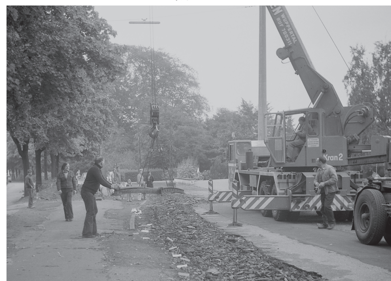
Ausbau einer Weiche am Friedenshain (1973)
