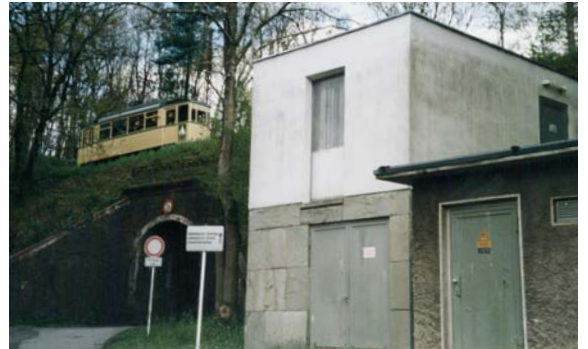
Das in Eigenbau entstandene Unterwerk versorgt die Bahn mit Strom.
