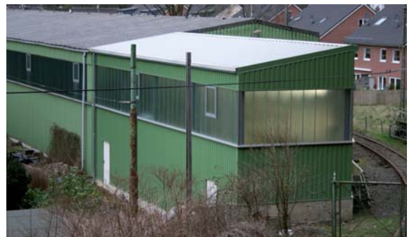
Der neue Werkstattanbau schafft Raum für Restaurierungsarbeiten.
